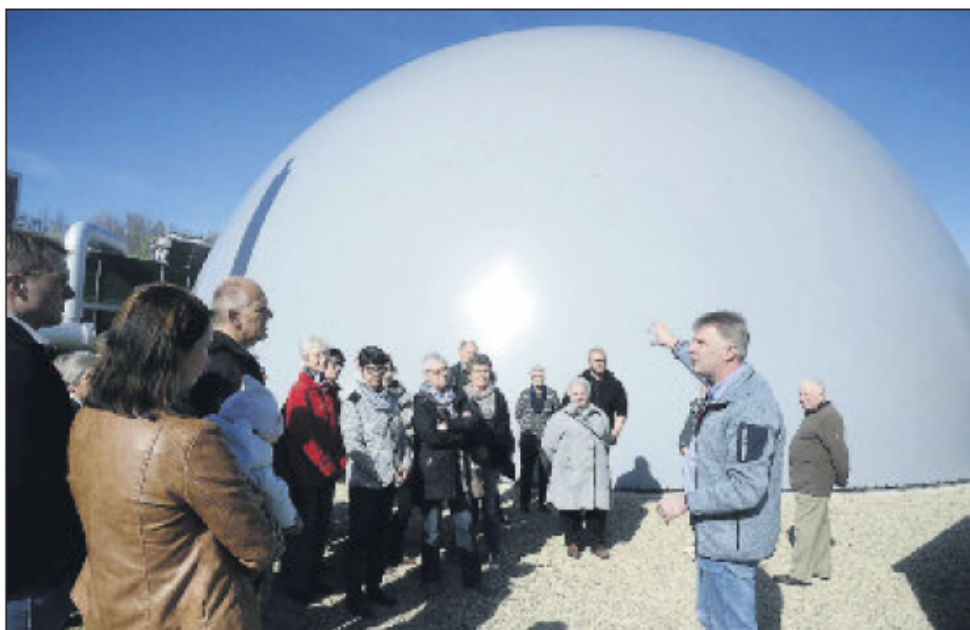
Eine 60-köpfige Gruppe lässt sich auf Einladung des Detfurter Ortsrates die neue Anlage samt imposanten Gasspeicher von Heiko Räther erklären. ■ Foto: Vollmer
