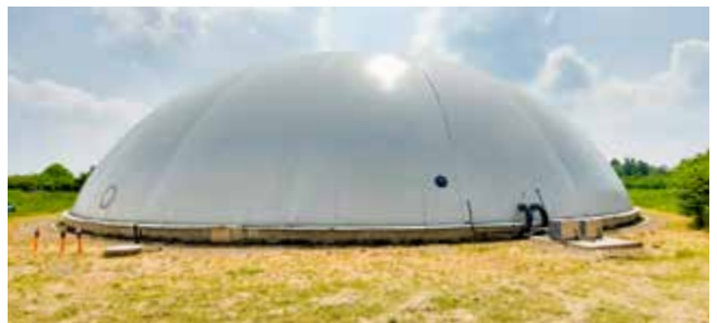
Gasspeicher der Biogasanlage - Durchmesser 39 Meter, Höhe 12 Meter.
