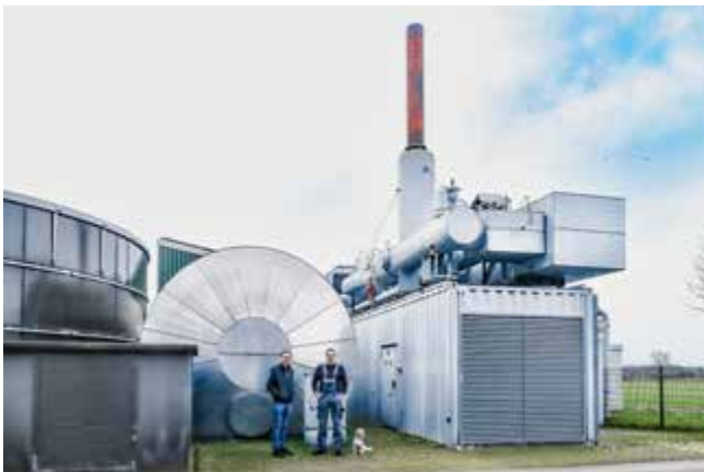
Bestmögliche Raumausnutzung: Der 150-m 3 -Liegendspeicher parallel zum BHKW auf der Biogasanlage, hinter dem BHKW befindet sich ein weiterer 100-m 3 -Tank, der Wärme speichert.
