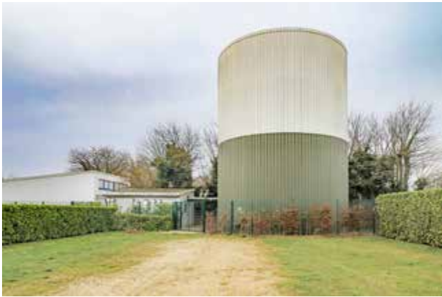
750-m 3 -Wärmespeicher an der Heizzentrale in Kevelaer.
