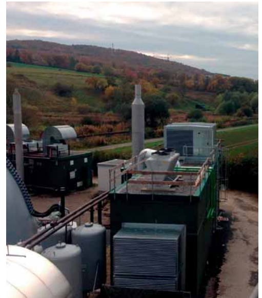
Quelle: Energethik Ingenieurgesellschaft mbH
